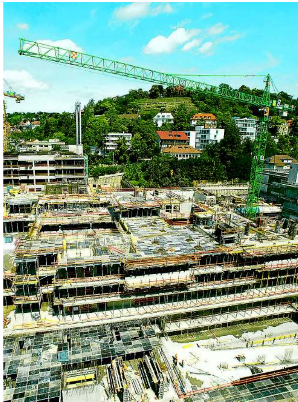
Auch der Rohbau des neuen Olgäles kommt gut voran.
